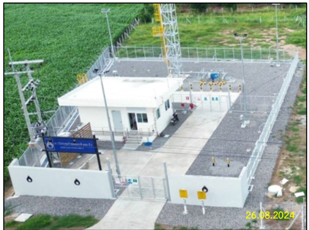
ง) การก่อสร้างสถานีควบคุมก๊าซธรรมชาติ (Block Valve Station)
